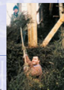
Schwarzdornhecken im Orbtal und im Gradierwerk: Verästelt und stabil eignet sich der Schwarzdorn (Schlehe) ideal für die Erstellung der Rieselwände in den Gradierwerken. Durch die Ablagerung von Mineralstoffen entsteht der Dornstein.
