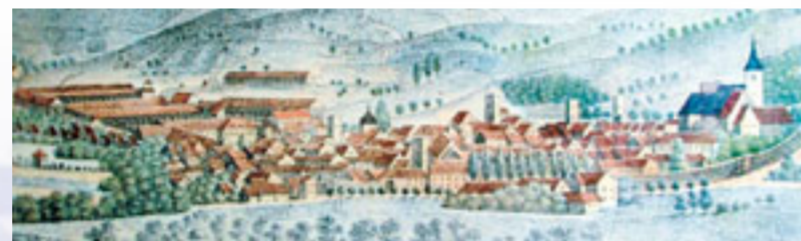
Die Mächtigkeit der Salinenanlage wird auf dieser Abbildung aus dem 19. Jahrhundert deutlich.
